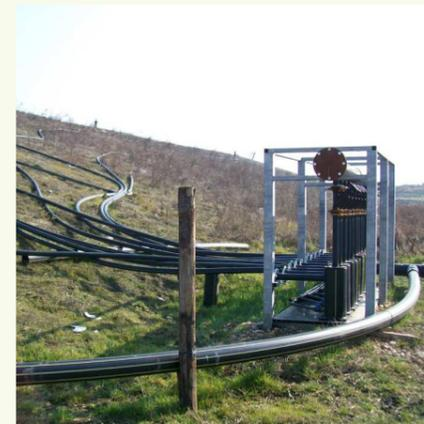
Stazione di regolazione del biogas
