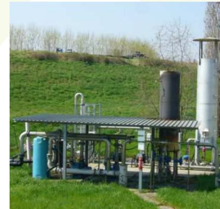
Torcia e impianto di produzione di energia elettrica
